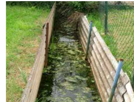
Verbaute und ungepflegte Gräben
